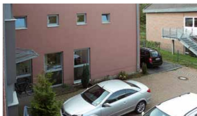
Haus Amselstraße, Jüchen
